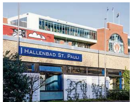
Das Hallenbad St. Pauli wird abgerissen und neu gebaut. FOTO: MICHAEL RAUHE
