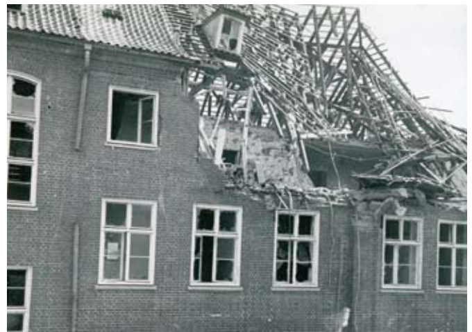
Zerstörtes Dach des Röntgenhauses
