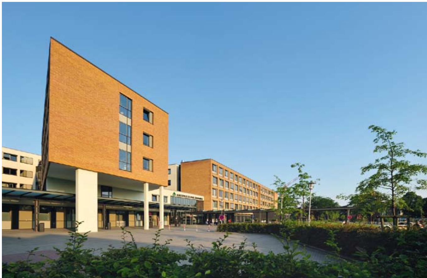
AK Barmbek, Ansicht von Nord-Westen
