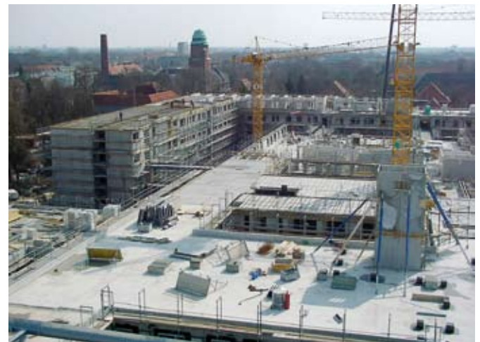
Das Krankenhaus im Rohbau am 1. April 2004
